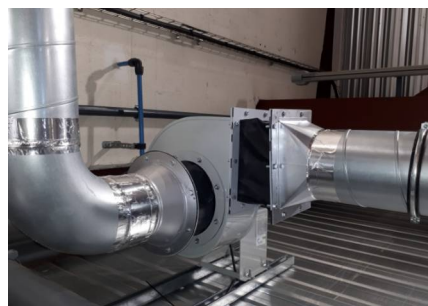
Exemples de raccordement de gaines par manchettes souples.
