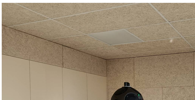
Exemple de réalisation de faux plafond acoustique en dalles de laine de bois.
